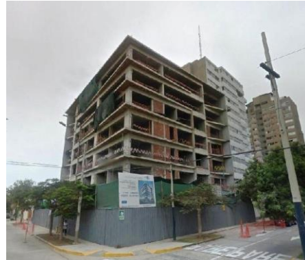
Figura 21. Esquema de estructura de pórticos de concreto
